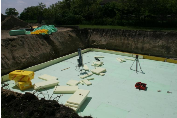
16cm XPS-Dämmung unter der Fundamentplatte
