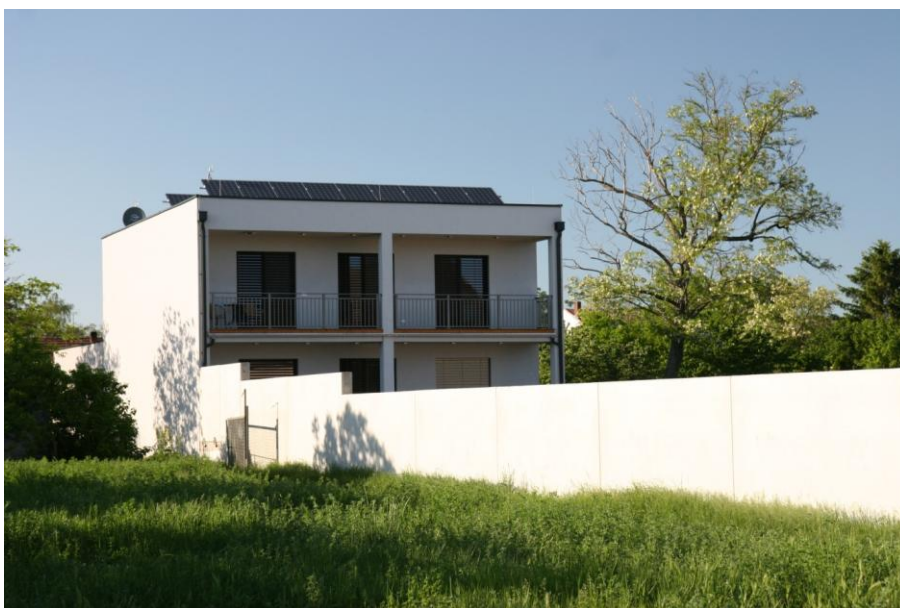
Das Plusenergiehaus nach Fertigstellung und Installation der 7,2kWp Photovoltaikanlage
